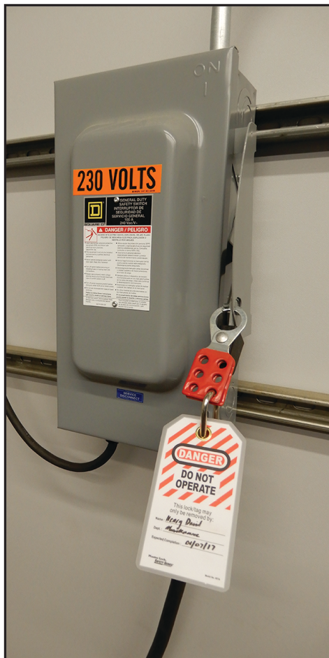
Figura SEGURIDAD-2: Bloqueo/Etiquetado del panel de fuente de alimentación
